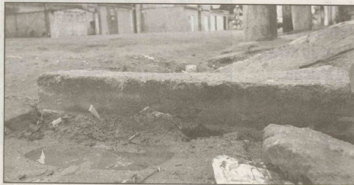
O que parece ser um monte de entulho é na verdade a entrada da Rua 21 de Setembro
